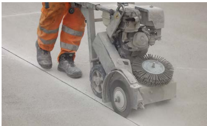
Fugenbürste im Straßenbau im Einsatz.
